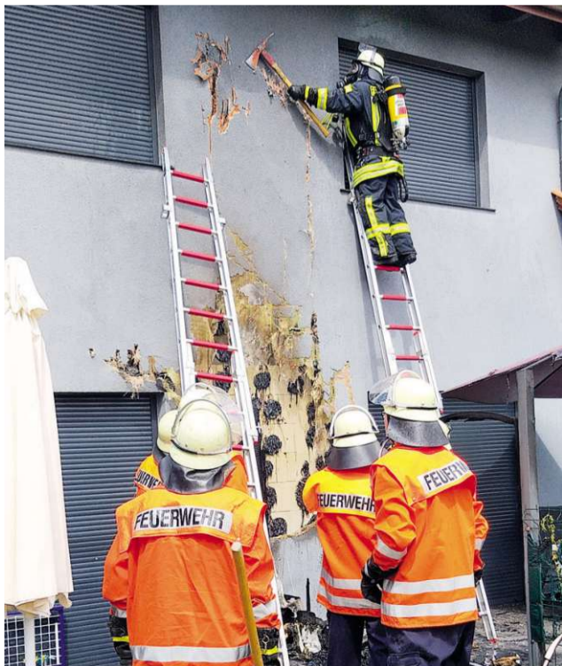
Auf Nummer sicher gingen die Feuerwehrleute, als sie das Wohnhaus nach versteckten Brandnestern in den Außenwänden absuchten.
