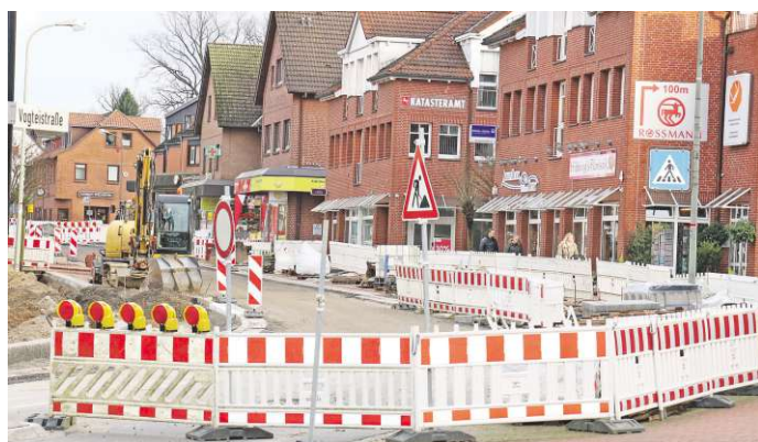
Dauert voraussichtlich noch bis Juli: Der Ausbau der Vogteistraße. ei
